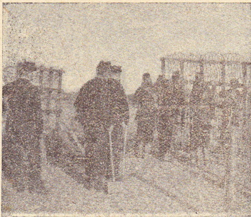
Aanleg van verdedigingswerken rond Antwerpen
